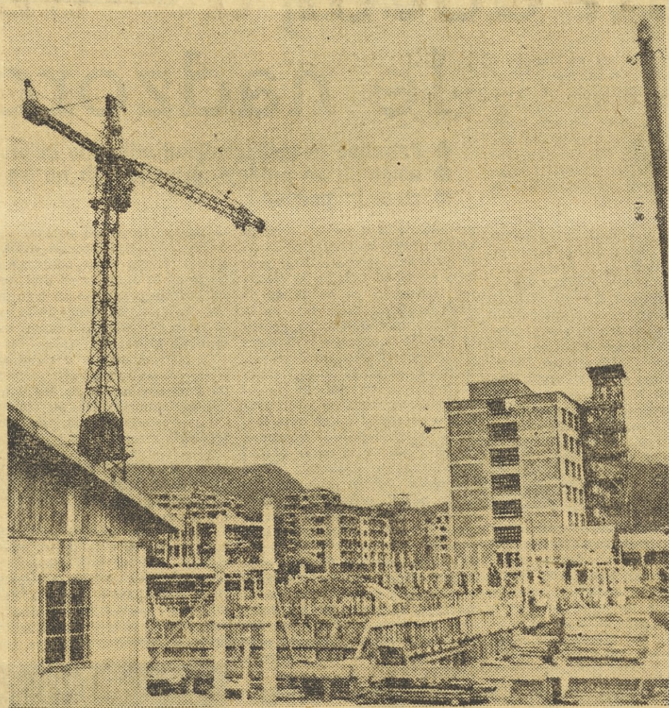
Velenje se razvija v eno od naših najlepših mest. Stolpnice in stanovanjski bloki rastejo iz tal kot gobe po dežju. V gradnji je okoli 400 stanovanj in s tem bo stanovanjska slika v Velenju v glavnem rešena. V naslednjih letih bo za prirastek prebivalstva in razvoj rudnika treba zgraditi vsako leto le še po kakih 100 stanovanj. Mimo stanovanjskih poslopij gradijo v Velenju še prostore za družabno življenje, novo šolo in pa upravno zgradbo rudnika. Zunanjo podobo Velenja pa oblikujejo prebivalci s prostovoljnim delom, ki je postalo za vsakega Velenjčana častna obveznost.
