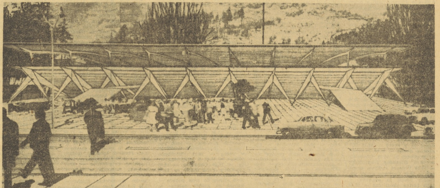
Na Jesenicah z vso vneto pripravljajo prizorišče svetovnega prvenstva v hokeju na ledu. Posnetek nam prikazuje maketo, kako bo izgledalo novo pokrito umetno drsališče pod Mežakljo. Kot smo zvedeli, dela pri gradnji uspešno napredujejo.
