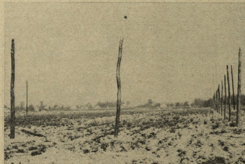
Lepa jesen omogoča dela v hmeljiščih in gradnjo novih žičnic. Na sliki gradnja nove žičnice na vrbanskem polju
