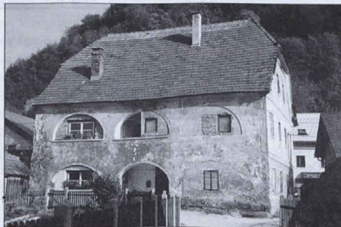
161 let stara neobnovljena hiša. (T.B)
