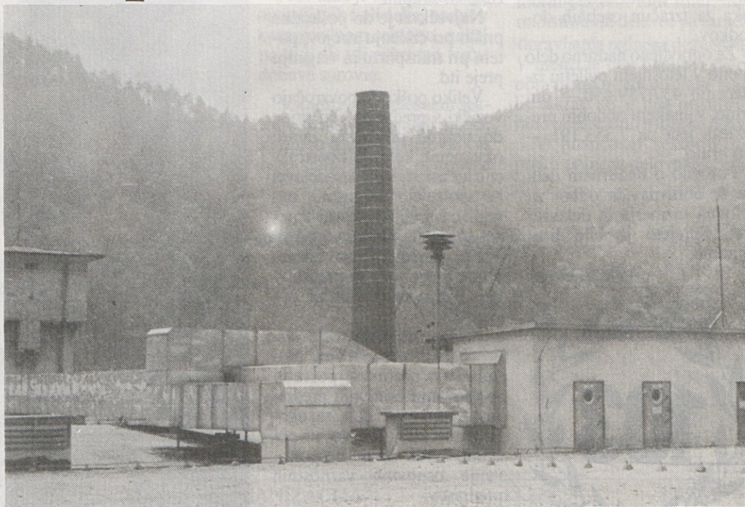
Odvodni kanali klima naprav so razvrščeni na strehi tovarne
