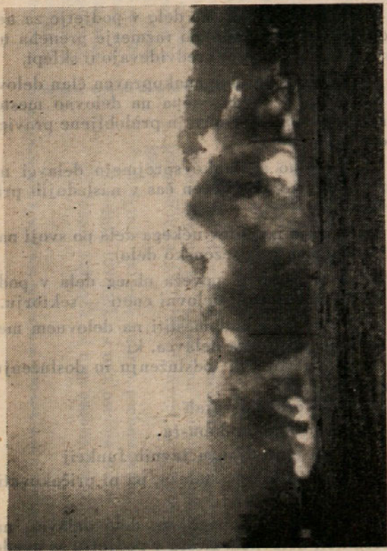
2. Priprava terena za Štore II — masovno miniranje
