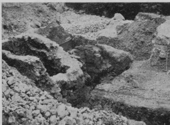
Slovenska peč v Dnu nad Kropo med izkopavanjem. V sredi talilni jašek, levo prostor talilcev (prim. Baš-Rekar, Slovenska peč, Ljubljana 1954; Vodniki Tehniškega muzeja Slovenije, št. 2)
