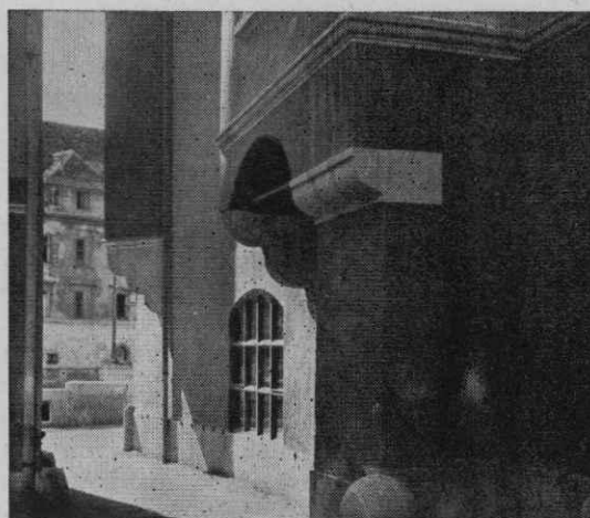
Rekonstrukcija pomola na Olupovi hiši Pod Trančo
