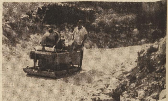
Bohn & Kähler-Rüttelverdichter mit seinem Betriebsgewicht und seinen Schwingschlagkräften bis 20.000 kg arbeitet auf Steigungen bis zu 20 Prozent und verdrängt die Straßenwalze
