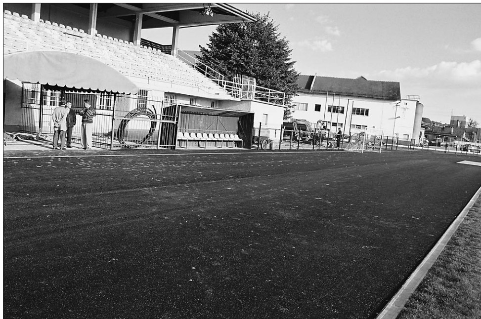
Pogled na del prenovljenega atletskega stadiona na Ptuj, ki sodi med najsodobnejše v Sloveniji.
