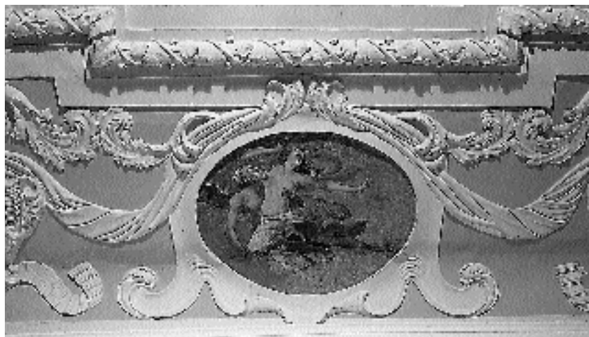
2. Štatenberg, dvorec, soba v prvem nadstropju, detajl, pred 1697
