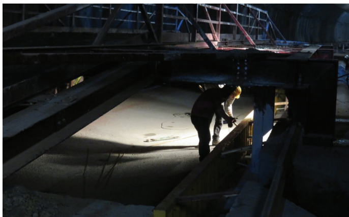
Slika 8. Betoniranje talnega oboka iz litega betona v polni širini predora.
