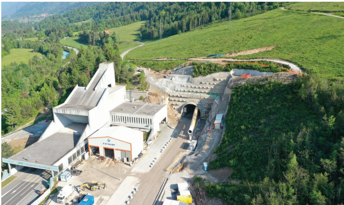
Slika 1. Začasní portal vzhodne cevi predora Karavanke.
