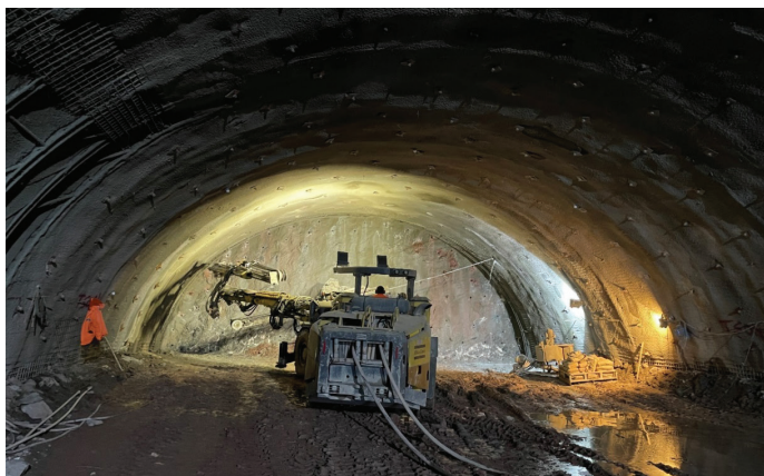
Slika 4. Vrtanje vrtin za miniranje.
