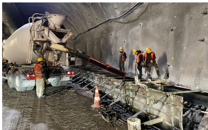
Slika 7. Betoniranje temeljev notranje obloge predora.
