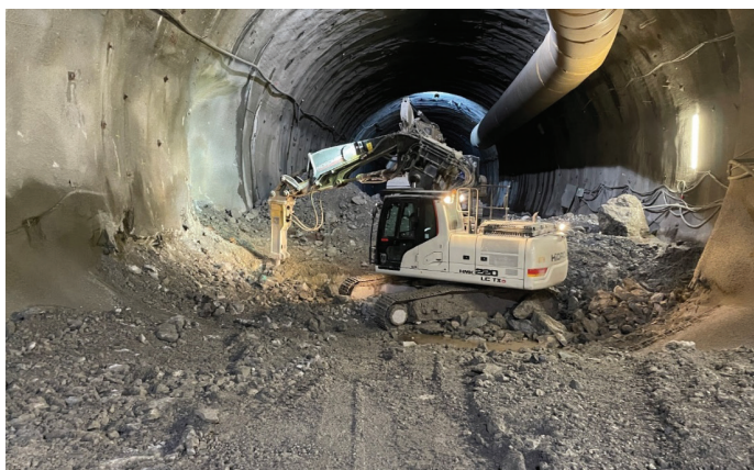
Slika 6. Izkop za talni obok iz brizganega betona.
