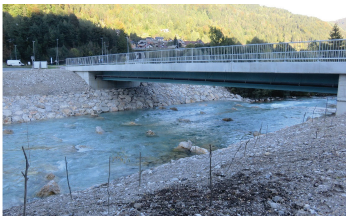
Slika 10. Dokončana izgradnja mostu M-2 (Hrušica) s priključnimi cestami.
