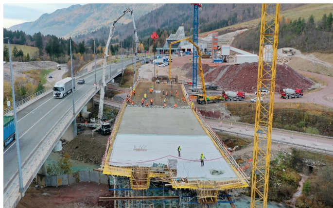
Slika 9. Betoniranje prekladne plošče mostu M-1 (1. faza).
