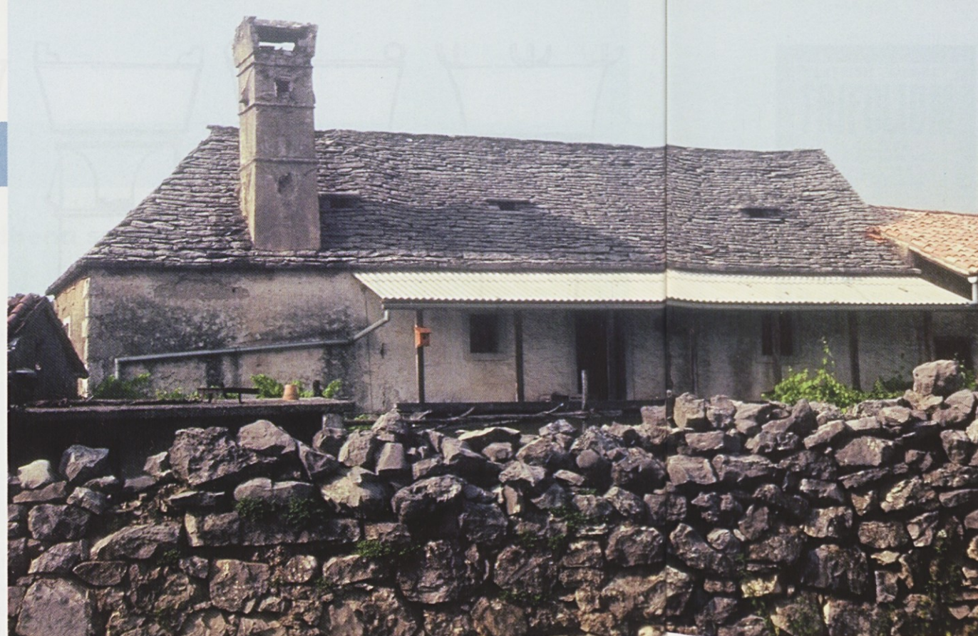
Hiša v Kozljah se ponaša z veliko skrlasto streho in z mogočnim kamnitim kaminom. Ogromne dimenzije imajo svoj razlog - boljši vlek: vrhni del kamina mora segati čez sleme skrlaste strehe. Širša kot je odprtina notranjosti, boljše je vase sprejemala dim izpod ognjiščne nape. Vetrobran je poškodovan (glej risbo 3).
