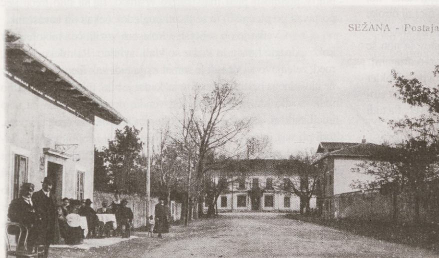
Pogled na železniško postajo
