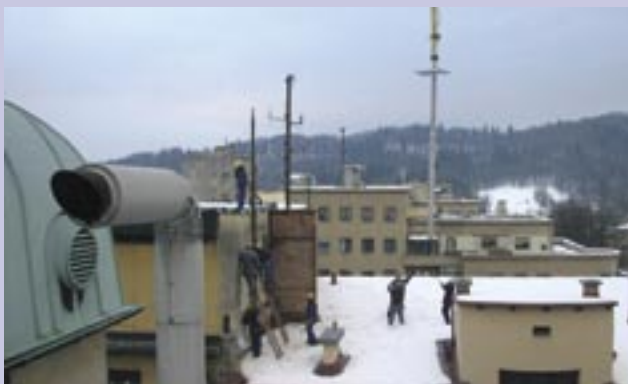
Montaža antenskih drogov na zasneženi strehi.
