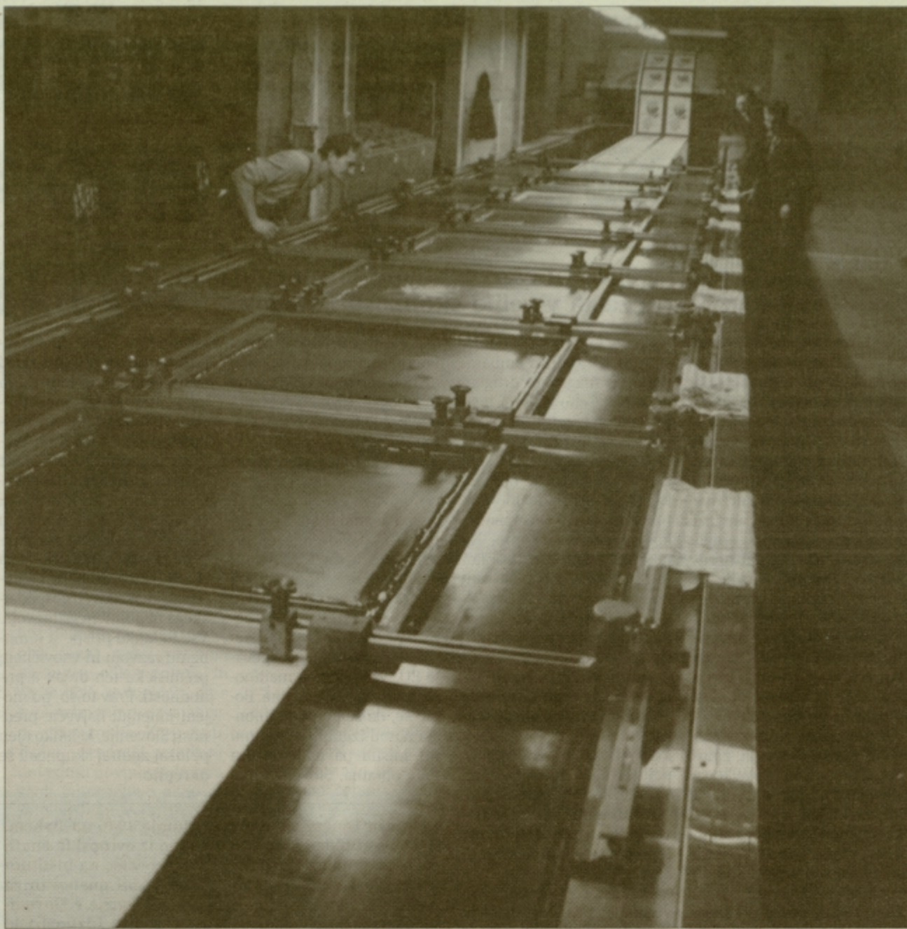
Ena zadnjih naložb v TT Prebold je nakup rabljenega ploskega šablonskega tiskarskega stroja, ki je v TT obratoval od začetka leta. (Foto: D. NARAGLAV)
