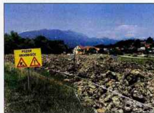
Na Šmidovem travniku, kjer so že začeli graditi infrastrukturo, bo do spomladi zraslo predvidoma 170 stanovanjskih enot.
