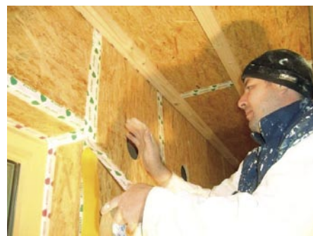
Slika 8 • Kakovostna montaža in natančno polepljeni stiki so ključni za zagotavljanje zrakotesnosti objekta
