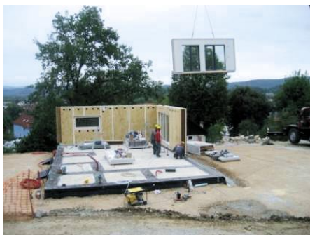
Slika 7 • Montaža objektov je hitra, brez odpadkov in natančna
