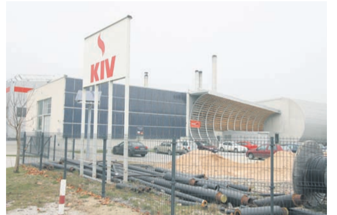
Energetika projekt občanom nudi daljinski sistem ogrevanja na lesno biomaso od leta 2004. Uradno so ga odprli maja 2005.
