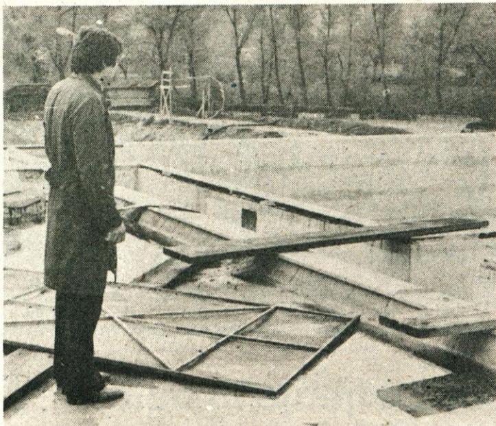
Na dvorišču Usnjarne so gradbena dela za kemično čiščenje odplak, pričakujejo pa, da bo dokončno zgrajena do jeseni.
