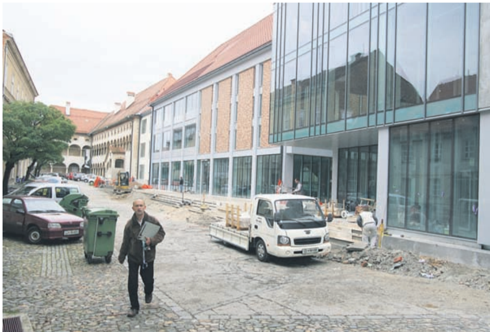
Denar za ureditev Muzejskega trga je bil zagotovljen že v sklopu zaključnih del pri novih prostorih knjižnice, a so konec leta 2009 v mestni občini izvedeli, da bo na smernice, kakšna naj bi bila najbolj primerna ureditev, treba počakati eno leto.
