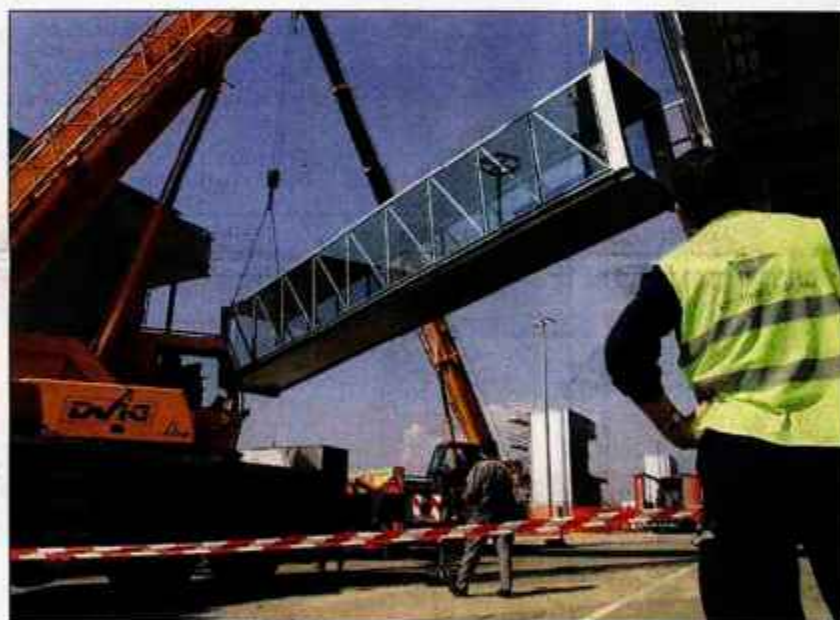
Ta teden so na Letališču Ljubljana montirali prve štiri aviomostove. Foto: Corard Kavčič
