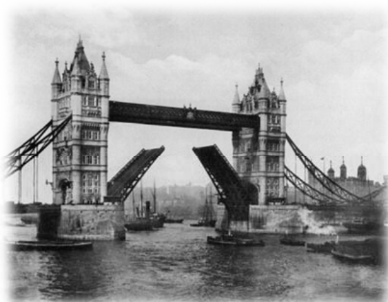
Slika 7 : Dvižni most v Londonu – Tower Bridge in Armstrongova pogonska hidravlika
