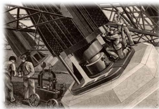
Slika 9 : Poravnavanje ploščadi Eifflovega stolpa med njegovo gradnjo (La Nature, Paris, 1888)
