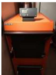
SLIKA 1: Uplinjevalni kotel na polena (25 kW)
