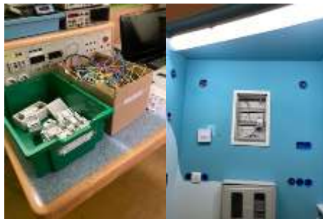
SLIKA 5: vezava inštalacij v instalacijskem boks.
