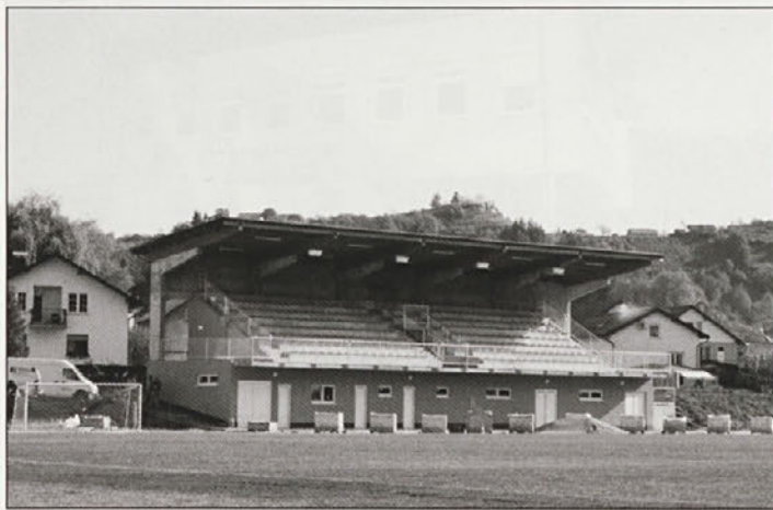
Tudi izgradnja športnega objekta s slačilnicami in pokrito tribuno je v zaključni fazi.
