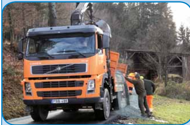
Na začetki meseca so mogli delavci eške zgotoviti bankine
