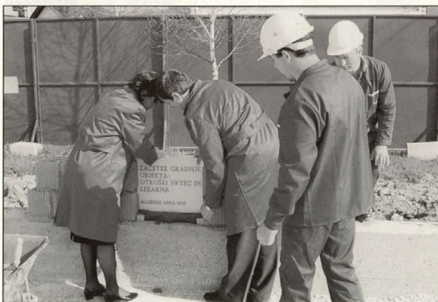
Zraven župana Franca Bezjaka je pri položitvi temeljnega kamna za novi vrtec prisostvovala državna sekretarka za šolstvo Teja Valenčič, ki je obljubila državno finančno pomoč pri izgradnji.
