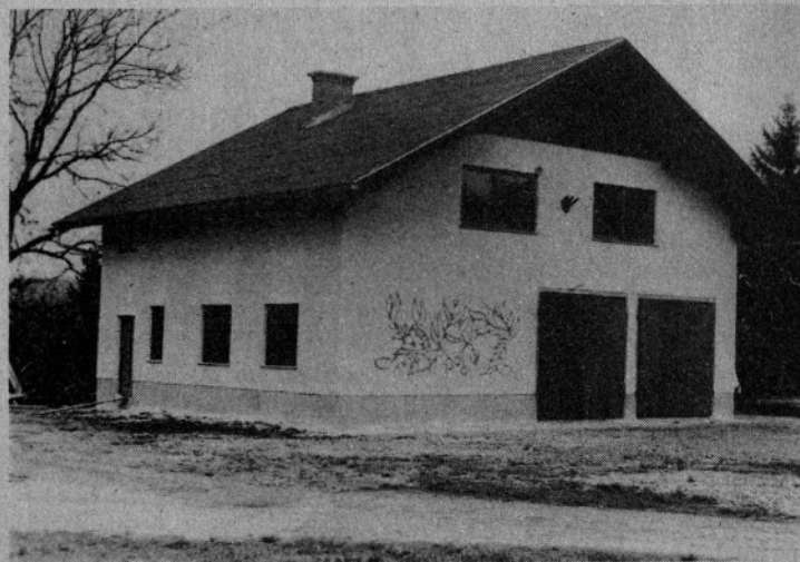
Nov gasilski dom na Pobrežju
