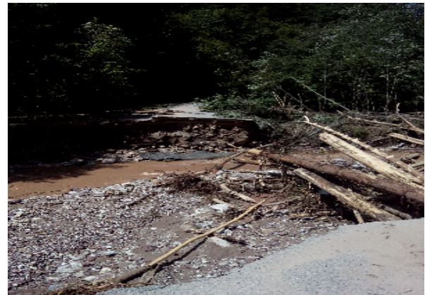
(b) Zaradi velike količine plavja je bila poškodovana cestna infrastruktura
