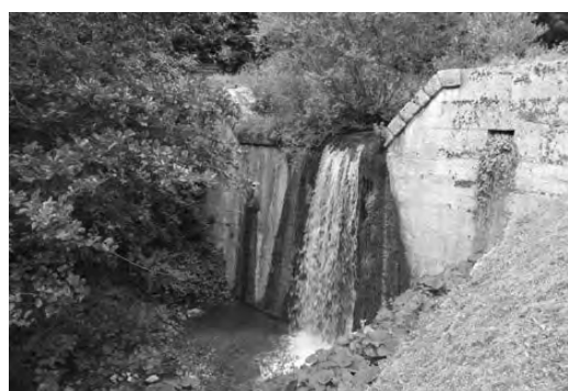
Slika 5: Hudourniška pregrada v strugi hudournika Mačkov graben
