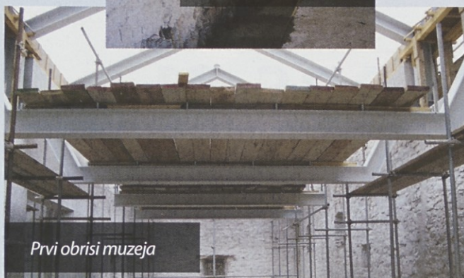
Svetlobna cezura med jekleno strukturo in zidom
