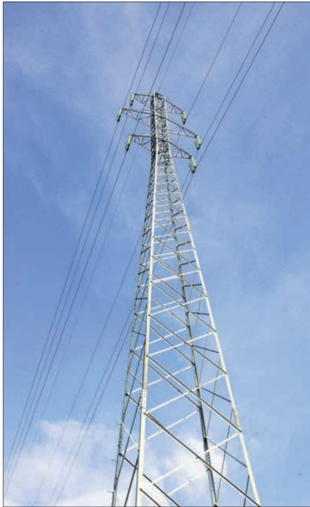
Delitev omrežnega in tržnega dela elektro podjetij naj bi določenim prinesla velike dobičke, odjemalci pa bodo zaradi manjših vlaganj in vzdrževanja omrežij potegnili kratko.
