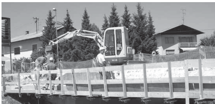
Dela na razširitvi hodnika za pešce na mostu so se tudi pričela
