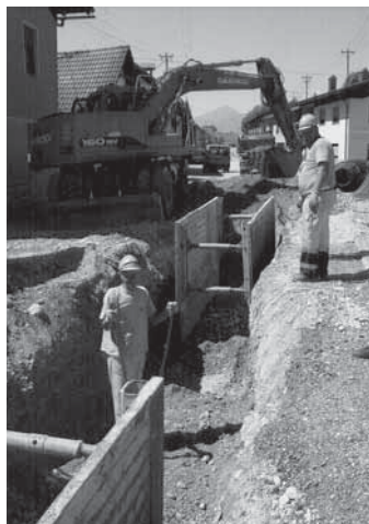
Vkopavanje (z razsipanjem) glavne kanalizacijske cevi na Prešernovi cesti
