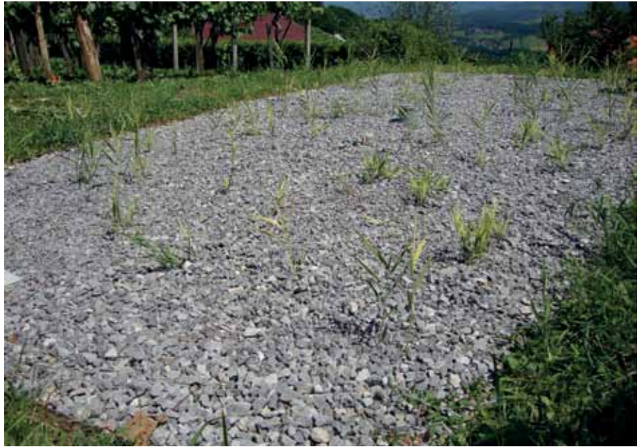
Slika 4: Rastlinska čistilna naprava za čiščenje odpadne vode (foto: A. Vovk Korže, 2012)
