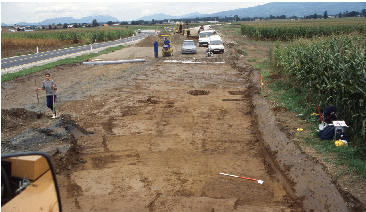
11 Pogled na rimsko cesto in izvedbo tampona za novo obvoznico.
