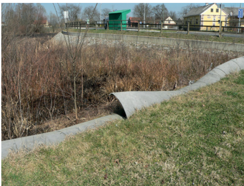
Cesta G1-3 Radenci–Petanjci. V letu 2002 so bile na odseku v naselju Petanjci na približni dolžini 500 metrov ob mrtvici Zaton postavljene plastične ograje ACO za dvoživke v kombinaciji z betonskim zidom (foto: Marijan Govedič, zgoraj, in Marta Jakopič, spodaj, obe 2006). Stanje ograje je v letu 2013 še slabše, saj je Direkcija za ceste še ni popravila.
