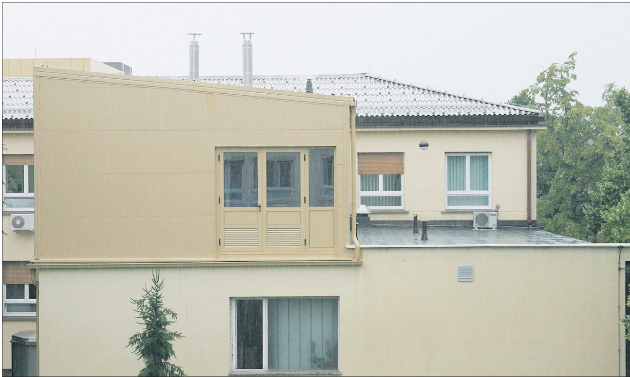
Zdravstveni dom Celje ima sedaj svojo kotlovnico. Delovati bo začela z novo ogrevalno sezono. Iz dimnikov, ki jih vidimo na fotografiji, se tudi potem ne bo kaj dosti kadilo, saj bo energent zemeljski plin.
