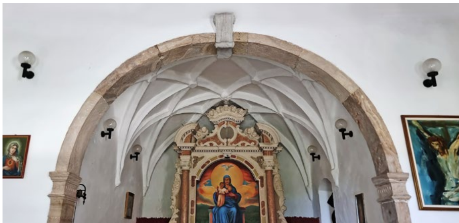
Gornji del slavloloka in obok z mrežasto shemo reber klinastega profila, ki se stikajo v okroglih in ščitastih sklepnikih. Foto Stane Seitl
