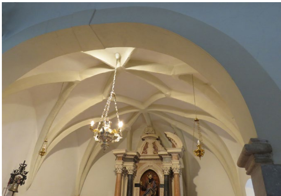
Zvezdasto-rombasti obok z rebri klinastega profila in preprostimi sklepniki
