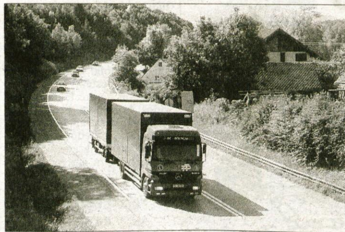
Med naseljema Bistrica in Žeje bodo zgradili 425 metrov dolg viadukt.
