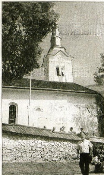
Zvonik cerkve sv. Jerneja je dobil novo streho in fasado.
