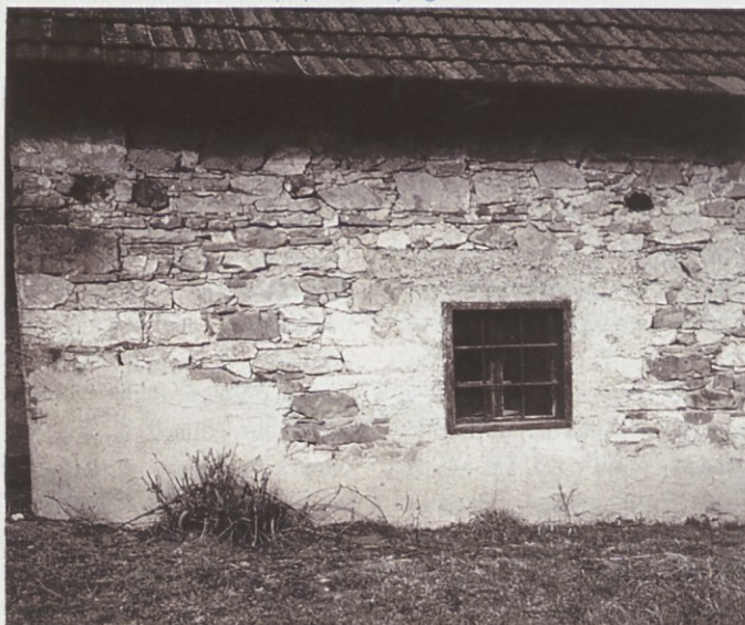
Slika 4: Gospodarsko poslopje v Zgornji Košani. Svetlejši kosi so iz apnenca, nekoliko temnejši iz flišnega peščenjaka. Obe kamnini sta v tamkajšnji okolici pogosti.
