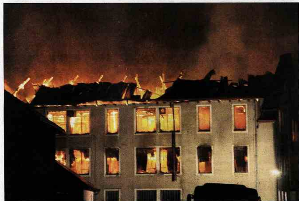
»Težko in predvsem nevarno je bilo gašenje v notranjosti skladišča. Stavba je visoka okoli 40 metrov, zato smo potrebovali lestve poklicne enote iz Celja in lestvi velenjskih in žalskih društev,« je intervencijo komentiral poveljnik PGD Prebold Darko Kranjec. (Foto: Tim Einspieler)
