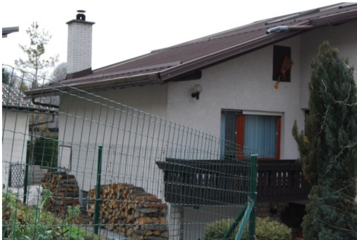
Slika 3: severovzhodna in severozahodna stran prizidka
