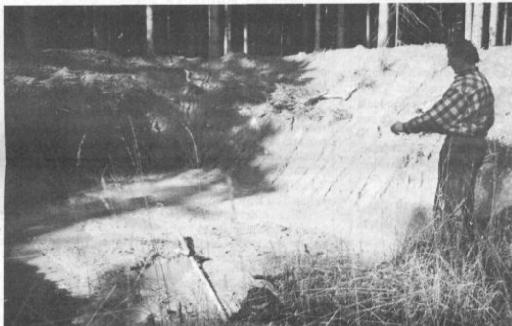
Izkop za rezervoar je že narejen.
