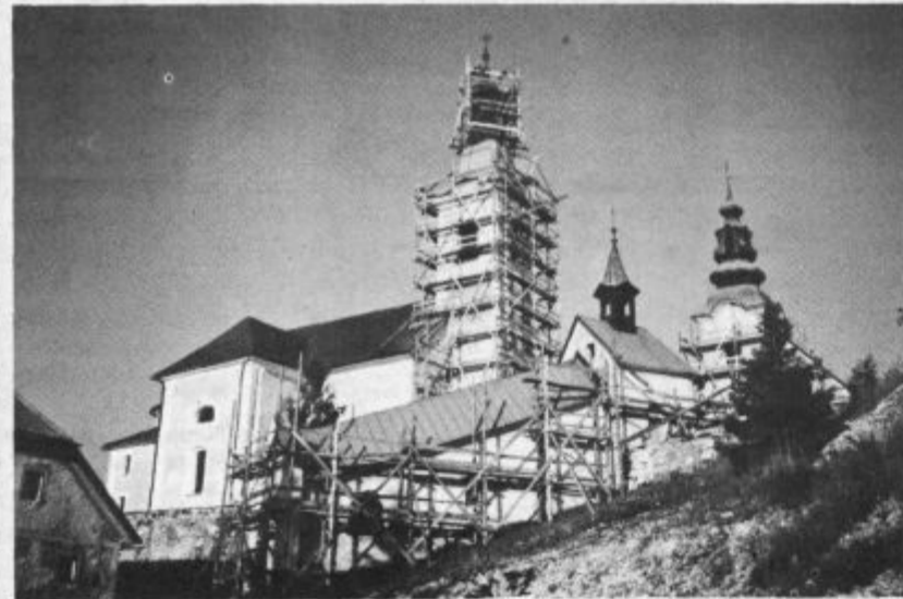
Obnova cerkve sv. Križa nad Belimi Vodami je najbolj "svež" dokaz, da ljudje radi sodelujejo. Naj bo tako še na ostalih področjih življenja in dela
