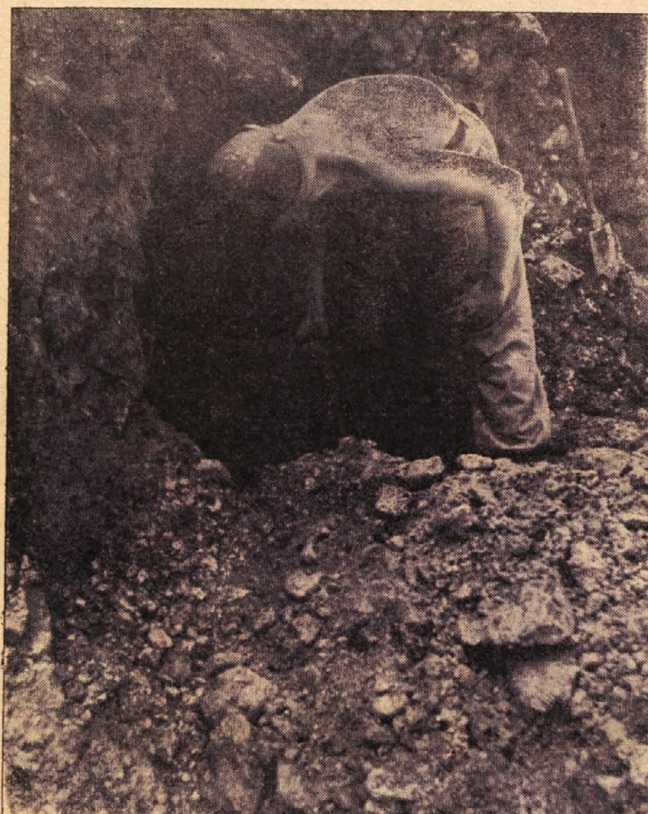
Tale na sliki pripravlja jamo za mino. Z miniranjem si pripadniki JLA pri gradnji nove Zasavske ceste lajšajo težko delo
