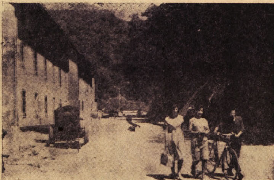
V Trbovljah bodo te dni začeli z urejanjem gornjega ustroja cestišča na odseku Sušnik-železniška postaja
