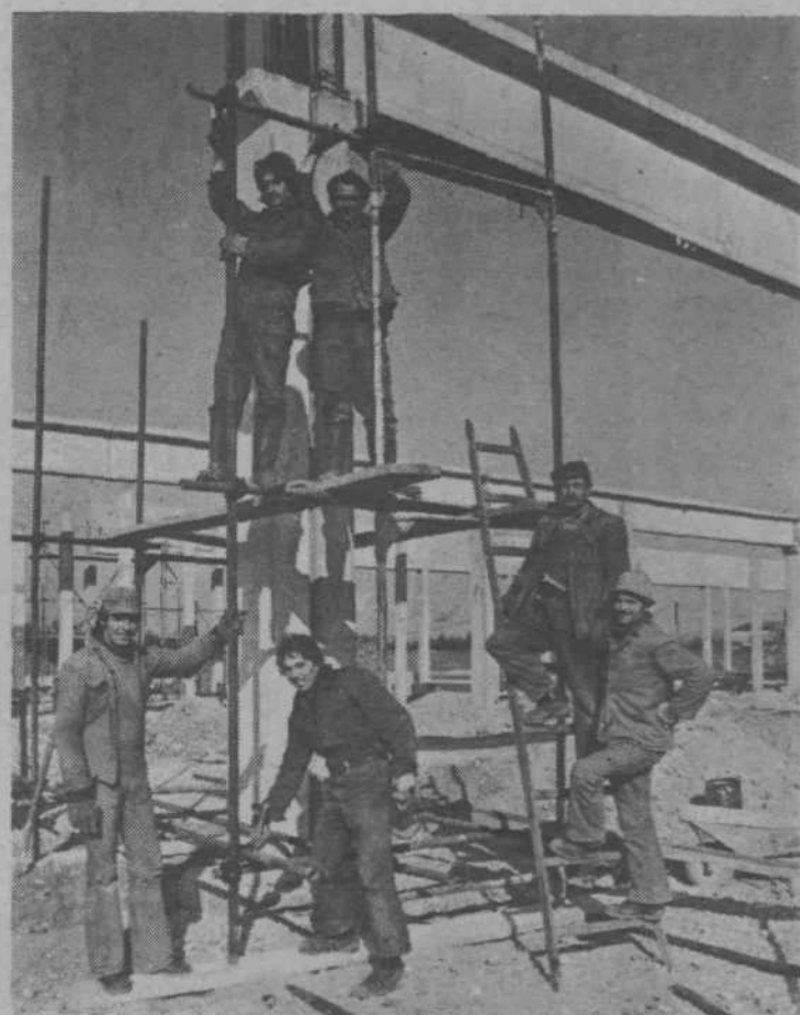
Tako kot jesti in piti je človek primoran tudi graditi. Toda kako graditi? Ali ni prav na področju gradbeništva še ogromno neizkoriščenih rezerv za stabilnejše gospodarstvo? (Na fotografiji so delavci GP Pionir pri delu v industrijski coni letališče Polje (Foto S. Gerlica)
