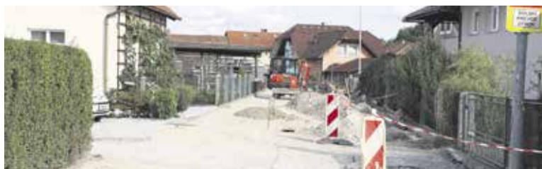
Na Podrečju nadaljujemo z obnovo cestišča.
