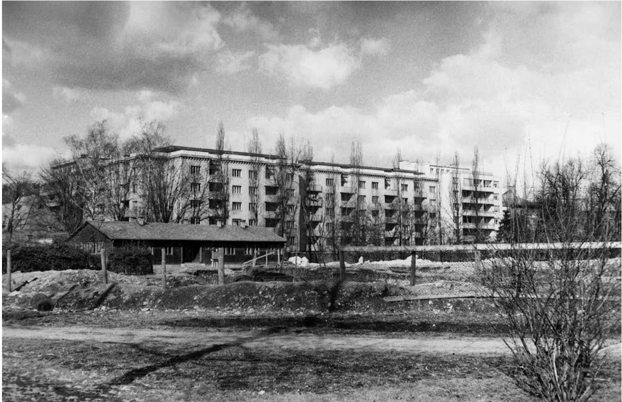
Pripravljalna dela za podzemno garažo na gradbišču pred Valvasorjevo ulico v Ljubljani, 1961. Avtor fotografije: Viljem Zupanc. (Vir: SI_ZAL_LJU/0342, Fototeka, A6-003-052)
