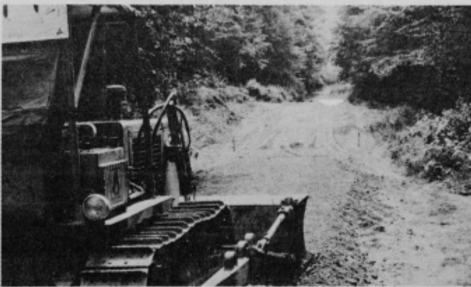
Zemeljska dela pred asfaltiranjem ceste Trnovska vas-Biščki vrh. Foto: R.
