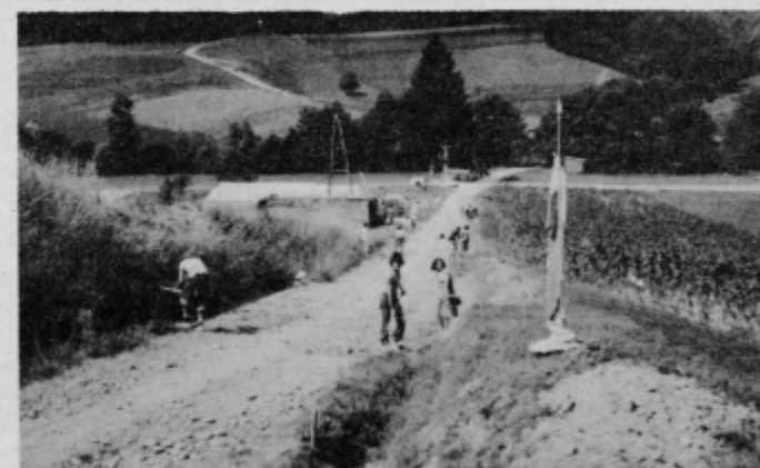
Brigadirji so opravljali težko delo na 3,6 km dolgi cesti.
