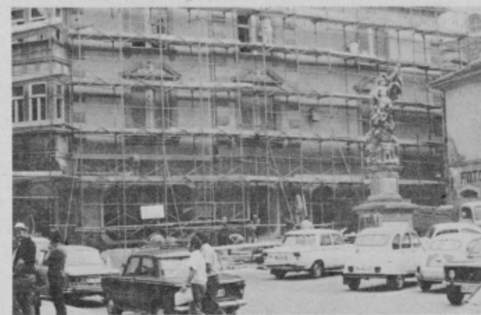
Kulturno-zgodovinsko zgradbo v Murkovi bodo v celoti obnovili iz sredstev tovarne „Peko“.
