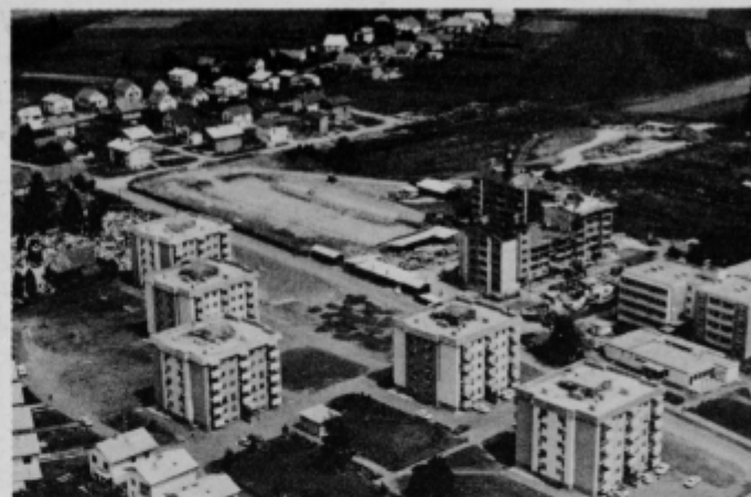
Intenzivna gradnja stanovanj ob Volkmerjevi v Ptujju se nadaljuje.
