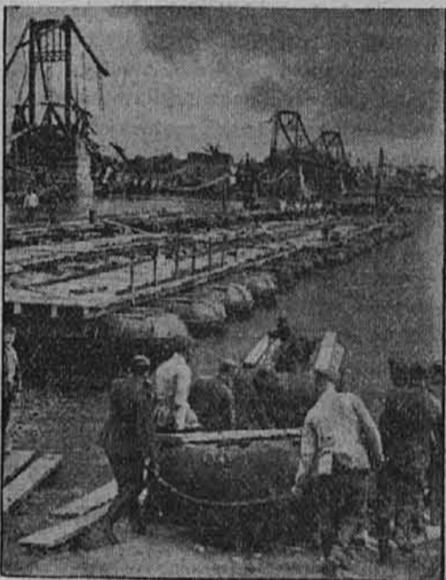
Gradnja mosta preko Dnjepra. Sovjeti so bili razstrelili vse mostove na Dnjepru pri Kijevu. Vendar so naši pioniri v teku 24 ur zgradili nove uporabljive prehode. — (PK.-Aufnahme: Kriegsberichter Mittelstaedt, Sch., Zander Multiplex-K.)
