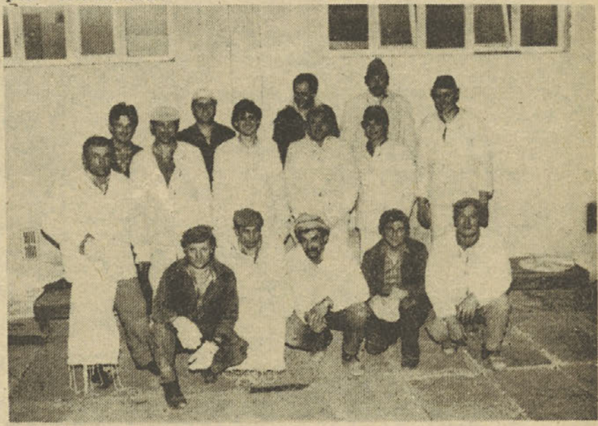
Skupina delavcev, ki je pri vročem remontu prenovila dve plinski komori II. peči – foto Z. Novak
