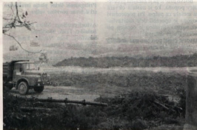
Pogled na gradbišče
