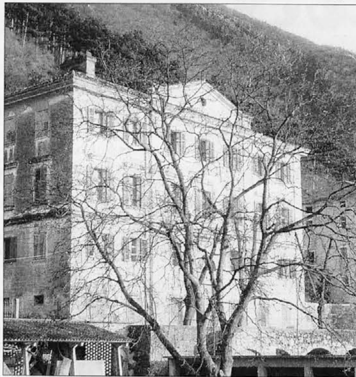
Na fotografiji vidimo staro stavbo vipavskega malega semenišča, ki je pred kratkim postala Škofijska gimnazija. Za to stavbo so v teh dneh pričeli graditi osem novih učilnic in večnamensko dvorano.
