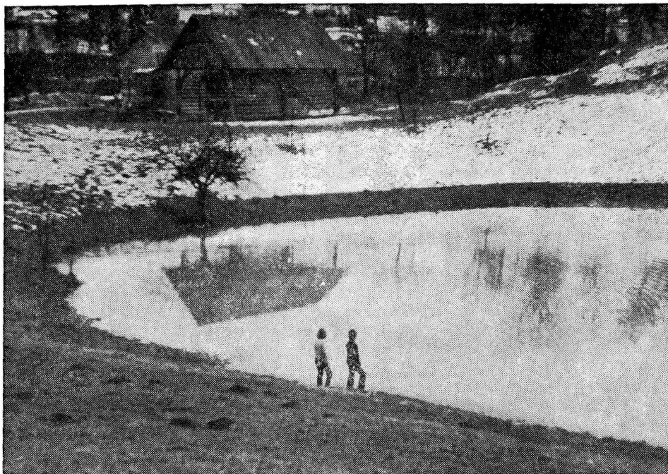
Sl. 3 Poplavljena Koševa dolina v zaledju Primcovega studenca Fig. 3. Flooded Koševa dolina in the hinterland of Primcov studenec
